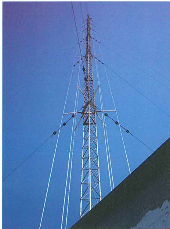
Monopolo dobrado duplo, em diplex para duas estações.
