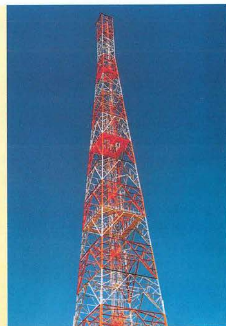
80 m disponível para locação em Goiânia
