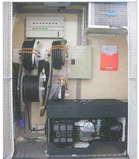
Fig. 4 - Parte traseira do veículo mostrando painel de conexão, gerador e ar condicionado
