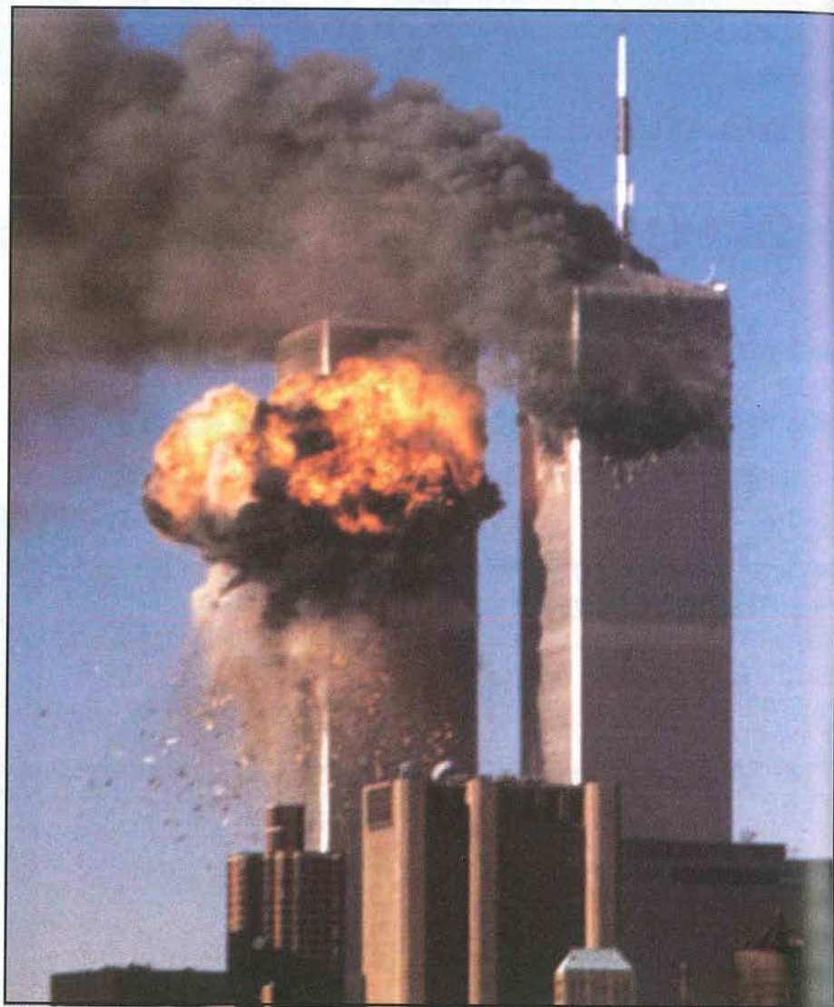
No topo da Torre Um estavam localizados transmissores de emissoras de TV e rádio de Nova York
