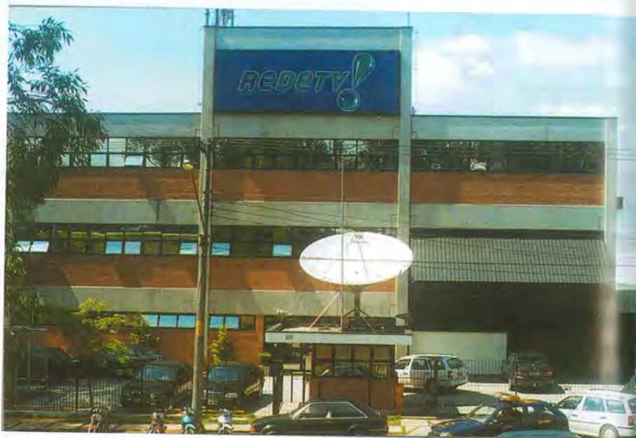
A sede da emissora, em São Paulo. A adaptação do prédio foi feita em seis meses
