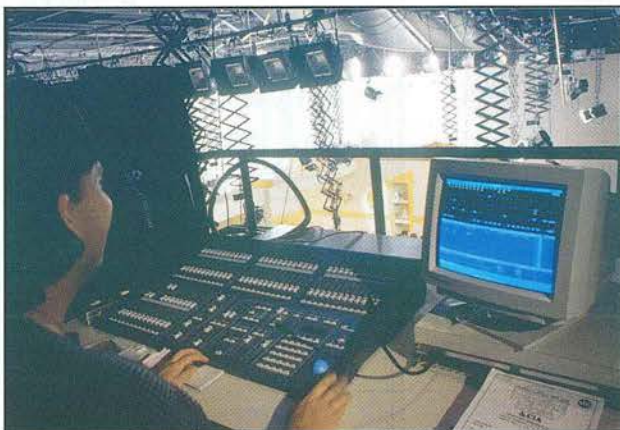
Mezanino de iluminação.
