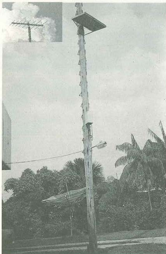
O sistema completo de recepção/retransmissão desenvolvido pela TV Amazonas.
